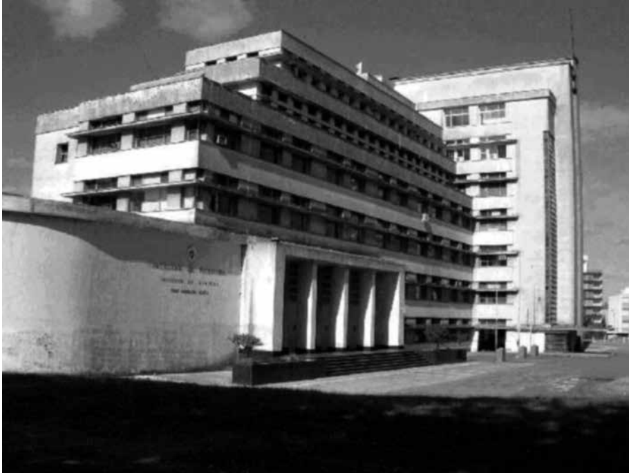
En la Planta Baja de este edificio del Instituto de Higiene, trabajó el Dr. Bernardo Porzecanski, junto al Dr. Juan Carlos Bacigalupi.
